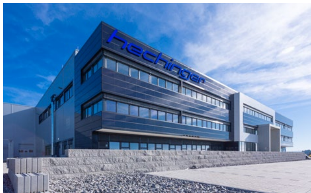
Der Neubau des Produktions- und Bürogebäudes der Hechinger Unternehmensgruppe hat eine Gesamtfläche von rund 15 000 m 2 . © Bild: Hechinger
